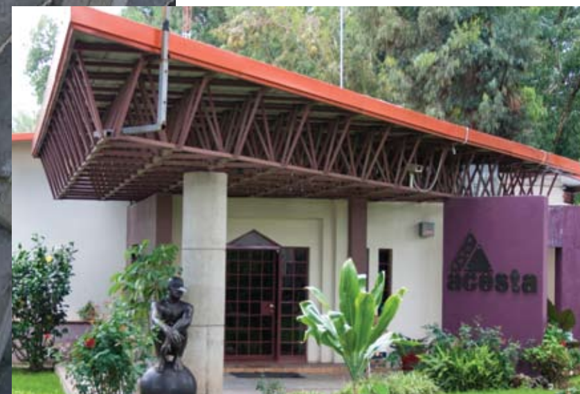
ARRIBA. Sede de la empresa en La Tijera. IZQUIERDA. Hospital Puerta de Hierro en Guadalajara.
