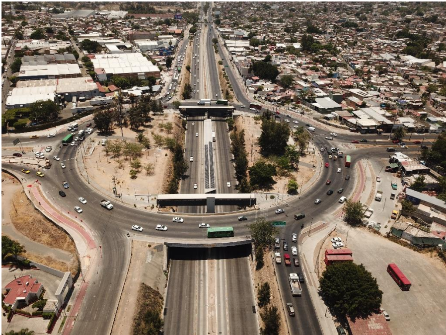
Imagen 5: Periférico Norte cruce Av. Alcalde
