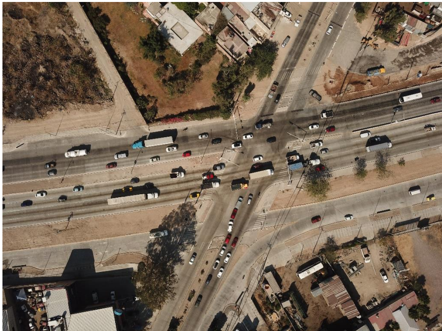
Imagen 19 Periférico Oriente cruce camino a Matatlán
