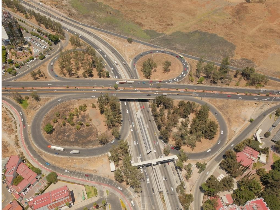
Imagen 10: Periférico Poniente Cruce Av. Vallarta
