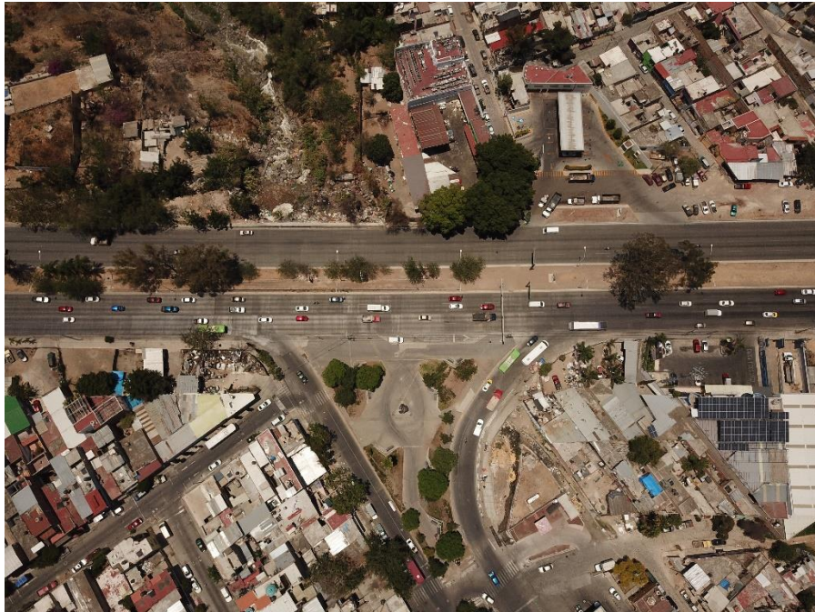
Imagen 2: Nuevo Periférico cruce con Av. Malecón
