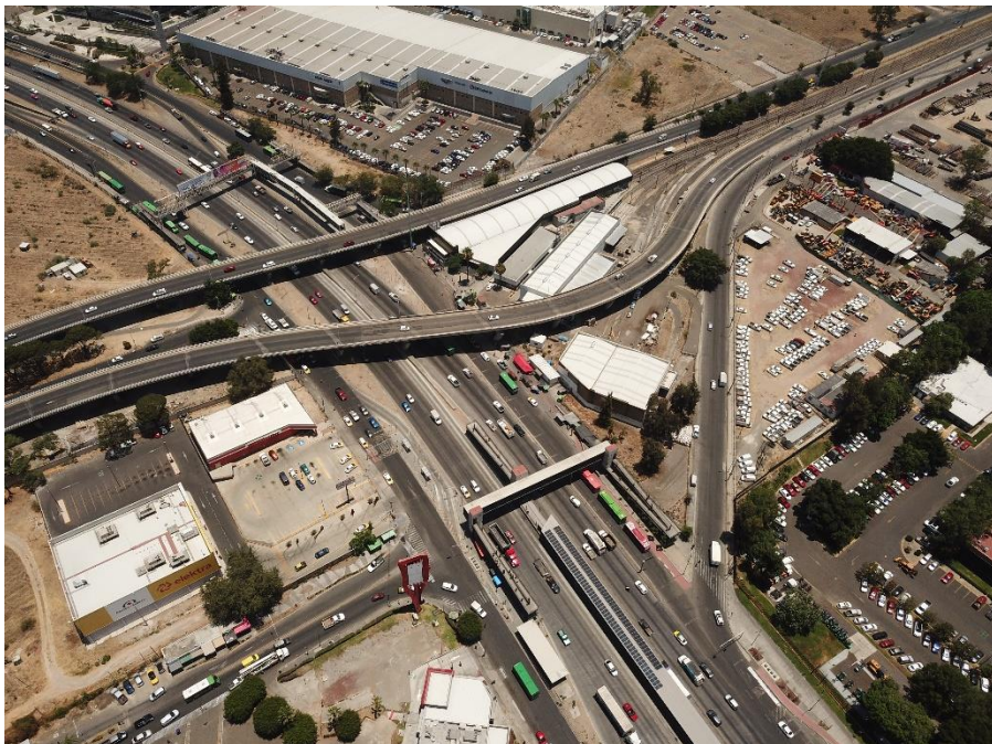
Imagen 13: Periférico Sur cruce Av. Colón
