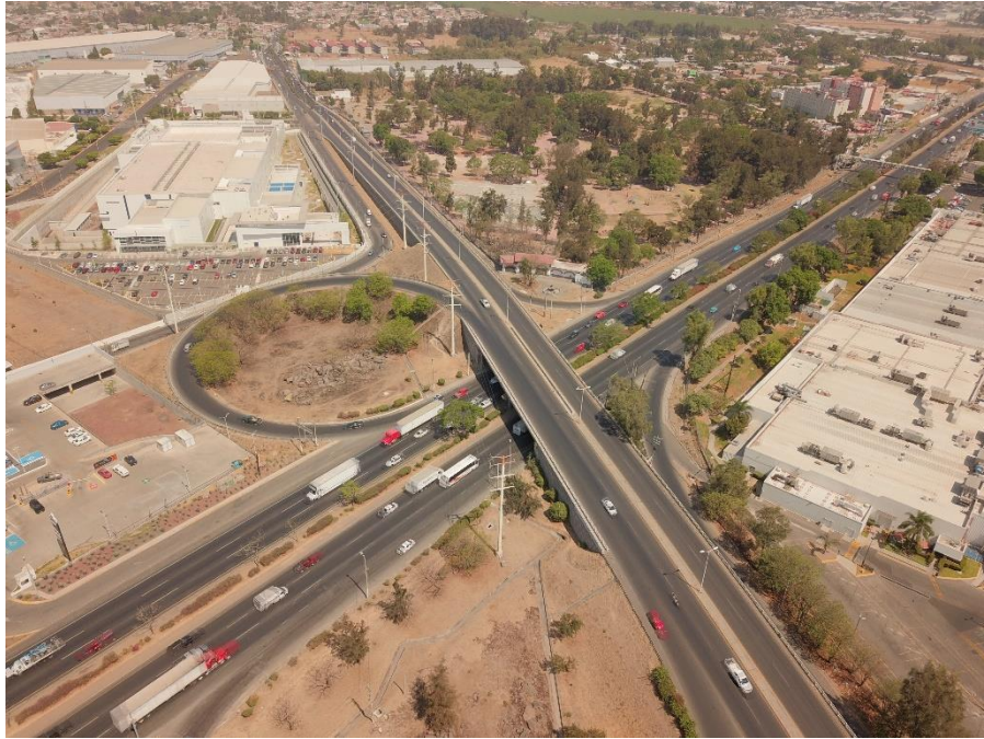
Imagen 16 Carretera Guadalajara El Salto cruce Carretera Chapala
